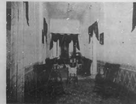
Hall o pasillo del Chalet del Sr. Luis Vega Pérez, en el Reparto Oña, en Sagua la Grande.
